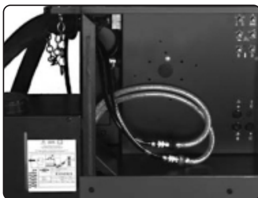
obr. 23 Montáž kabelů a přípojek
