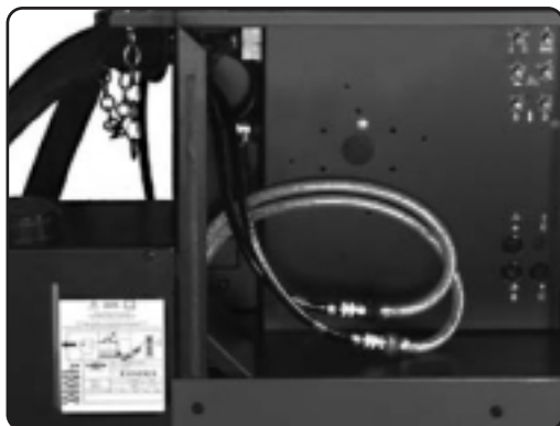
obr. 23 Montáž káblov a prípojok
